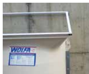
Lichtschachtabdeckungen aus Einseibensicherheitsglas (ESG) für Lichtschächte mit geschlossenem Boden
