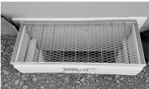
GFK-Montagedämmelement mit Sockelelement
