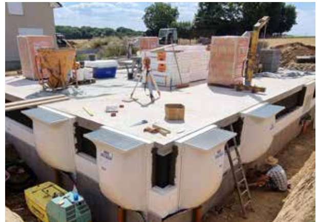
Montierte, druckwasserdichte PROFILichtschächte
