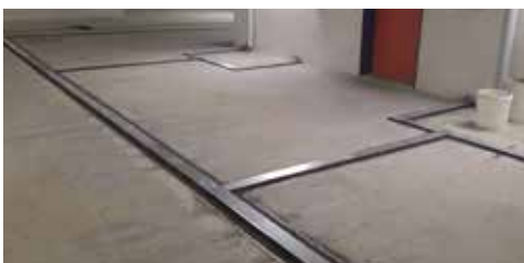
Montage AquaStop in Aussparung
