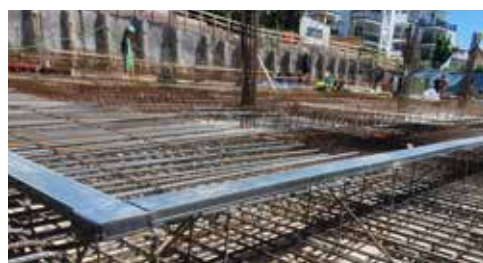
Montage AquaStop mit Rinnenaufständering
