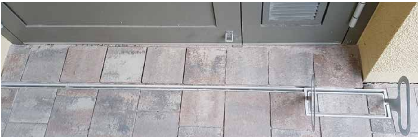
Eingang: Schlitzrinne mit Einlaufkasten inkl. Revisionsaufsatz und zwei Schlüssel
