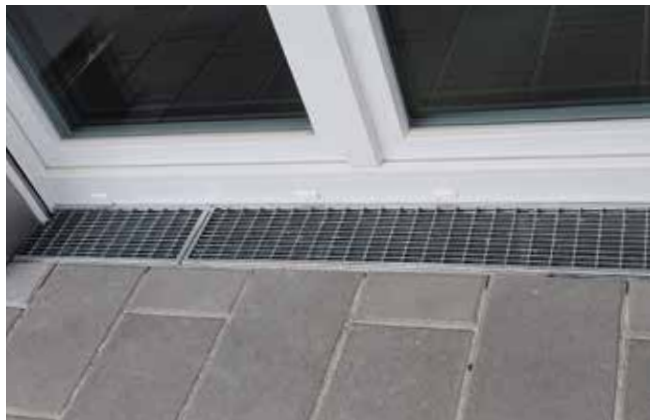
Terrasse: Fixo 150 mit Pressgitterrost 30/10
