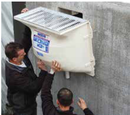
3. Lichtschacht mit Rost an den Fixankern einhängen und leicht anschrauben. Zusätzliche Befestigungslöcher bohren. In den Spalt zwischen Wand und Lichtschacht weiteres Kartuschenmaterial einspritzen.
