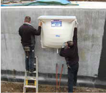
1. Rost einhängen und Grundbohrlöcher anreißen, bohren und Fixanker einschlagen.
