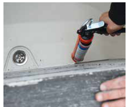
5. Lichtschacht mit dem restlichen Kartuschenmaterial innenseitig abspritzen. Die Abdichtung einen Tag aushärten lassen und danach schichtweise anfüllen und verdichten. Eine Belastung mit Wasser darf erst nach 24 Stunden erfolgen.
