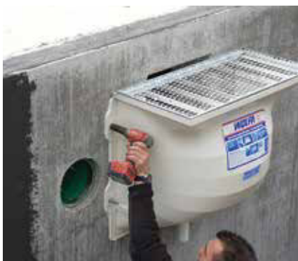
4. Das zusätzliche Schienenset anbringen und alle Schrauben handfest anziehen.
