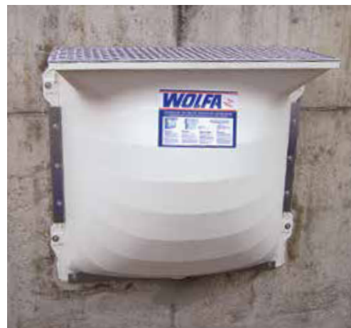
Montierter, druckwasserdichter PROFILIGHT-Schacht mit geschlossenem Boden
