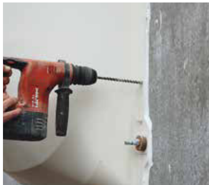
3. Lichtschacht mit Rost an den Fixankern einhängen und leicht anschrauben. Zusätzliche Befestigungslöcher bohren. In den Spalt zwischen Wand und Lichtschacht weiteres Kartuschenmaterial einspritzen.
