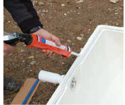
2. Abdichtungsband in die Aufnahmetut des Lichtschachtes einkleben und einen Teil des Kartuschenmaterials großzügig auf den Lichtschacht-Flansch auftragen.
