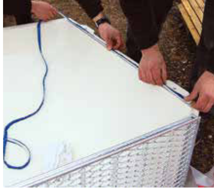
2. Abdichtungsband in die Aufnahmetut des Lichtschachtes einkleben und einen Teil des Kartuschenmaterials großzügig auf den Lichtschacht-Flansch auftragen.
