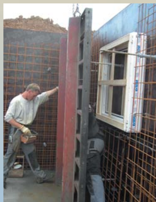
Place the inside formwork – pour the concrete
