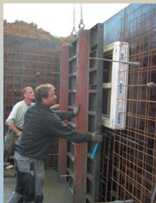
Place the inside formwork – pour the concrete
