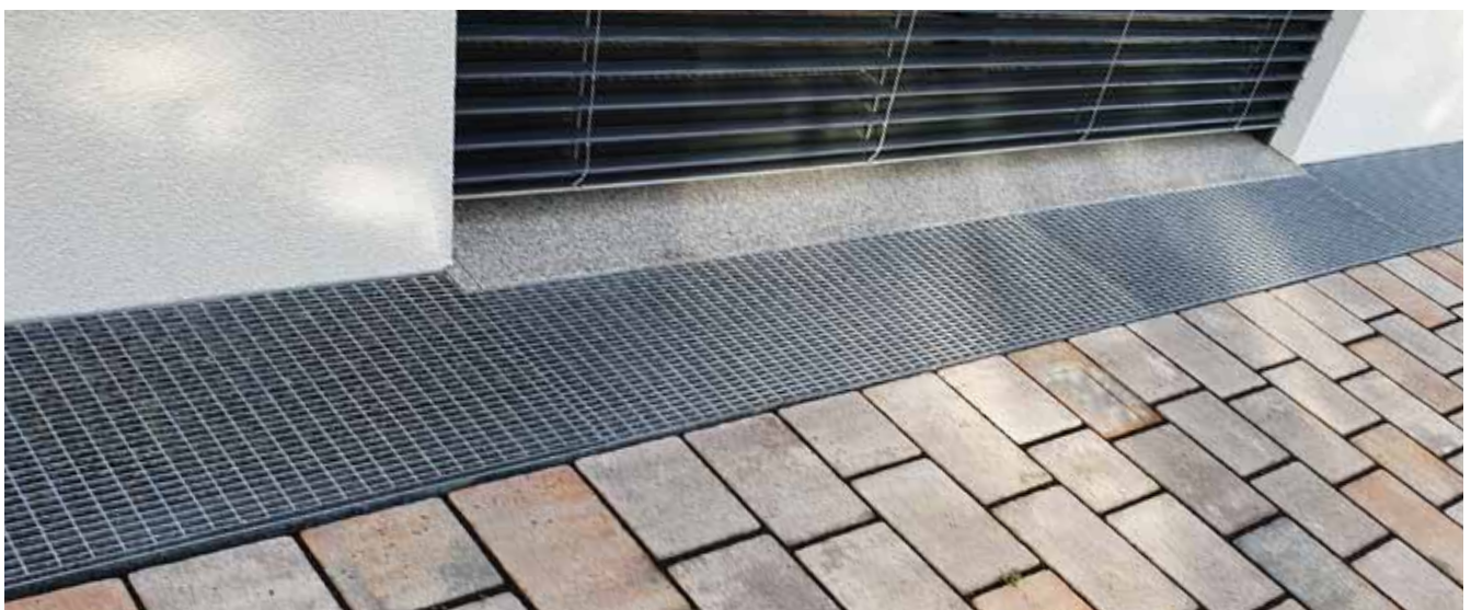
Sondergitterroste in Maschenweite 30/10 (hier als Spritzwasserschutz an Fertighäusern)
