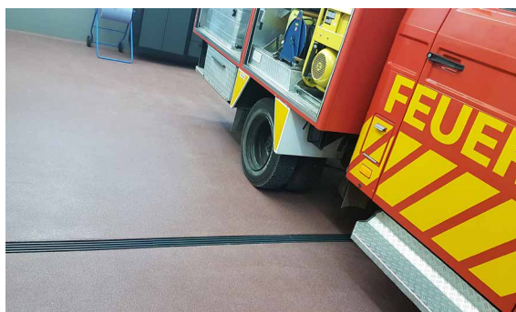
Anwendungsbeispiel 2 Montage in vorhandene Aussparung
