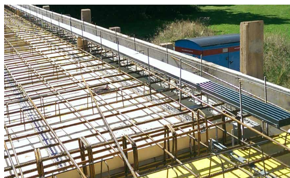
Anwendungsbeispiel 1 Montage mit Rinnenaufständerung
