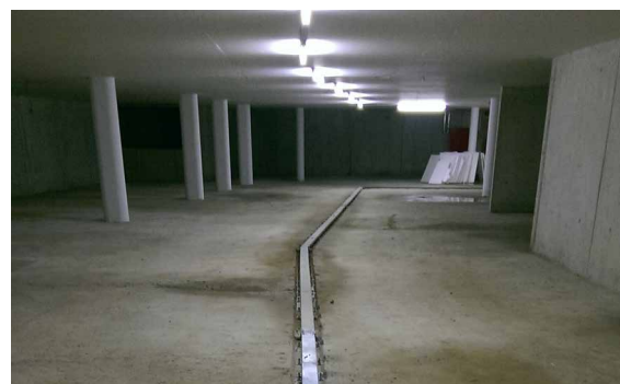
Anwendungsbeispiel 2 Montage in vorhandene Aussparung
