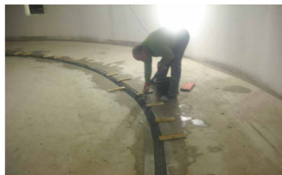
Anwendungsbeispiel 2 Montage in vorhandene Aussparung
