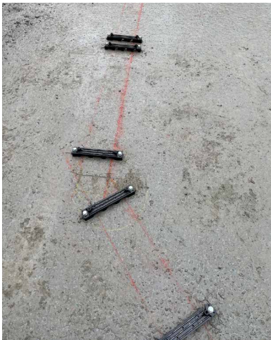
Kunststofffuß auf Sauberkeitsschicht aufschrauben.
