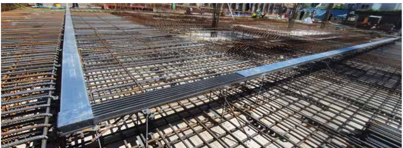
AquaStop-Rinne mit Rinnenaufständerung und Montageabdeckblech als Schutz beim Flügelglätten
