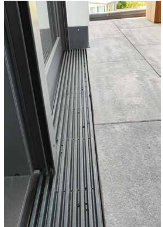
AquaStop Drain 150 (mit Drainagebohrung)
