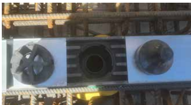
Einlaufstück gerade mit abnehmbarer Revisionsklappe und Ablaufanschlussmöglichkeit NW 125 oder NW 100
